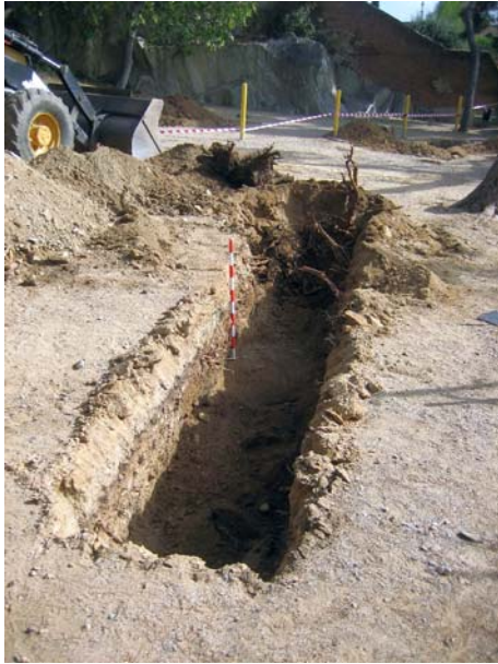
FOTO 29 – Vista del sondeig RE4
