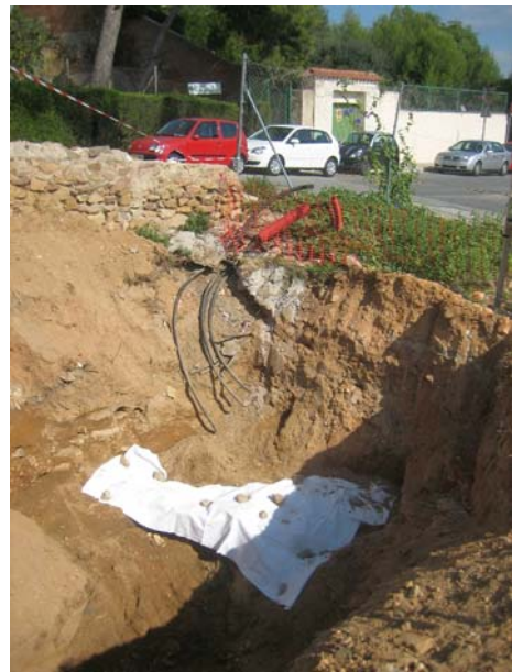
FOTO 04 – Estructura UE 103 abans de tornar-la a cobrir
