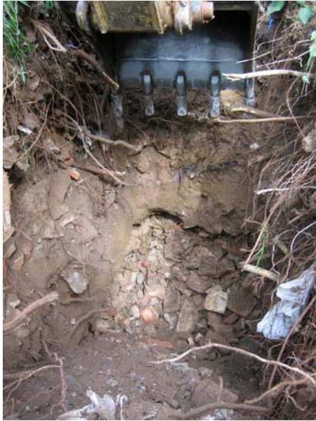
FOTO 33 – Vista parcial del sondeig RE8
